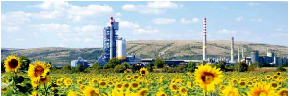
保加利亚Devnya水泥厂日产4000吨熟料生产线项目
